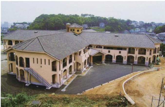
総合ケアセンター「明治清流苑」2006年6月施工
