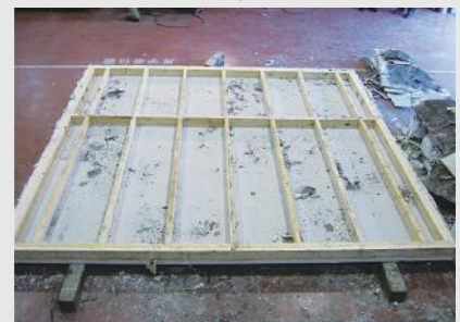
3時間後に解体。たて枠に一切、こげめが無い
