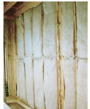
壁断熱材の施工例
