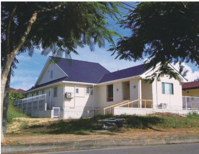
石垣島のツーバイフォーによる住宅兼診療所
